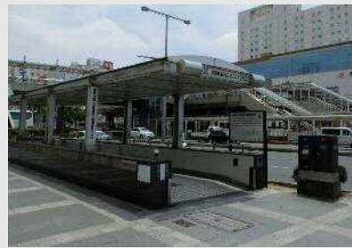
豊橋駅東口地下駐輪場の出入り口
